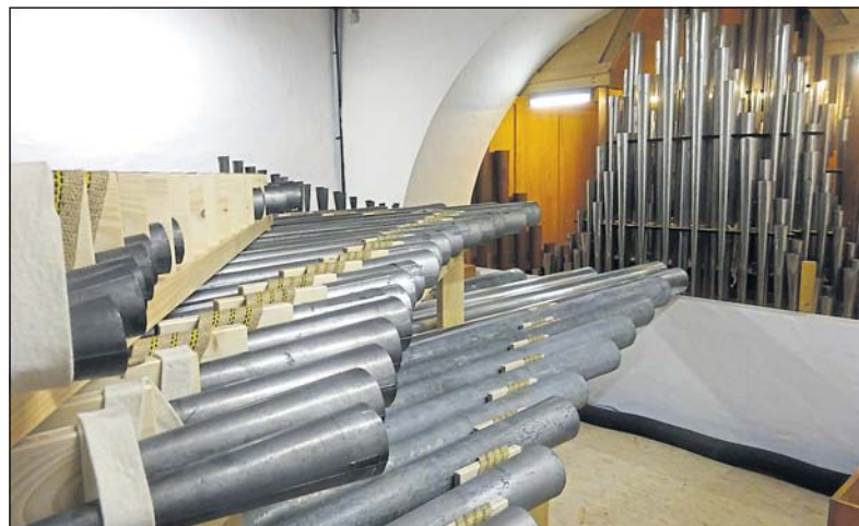
Die Spanischen Trompeten sind in die Orgel eingebaut und von außen nicht zu sehen.
