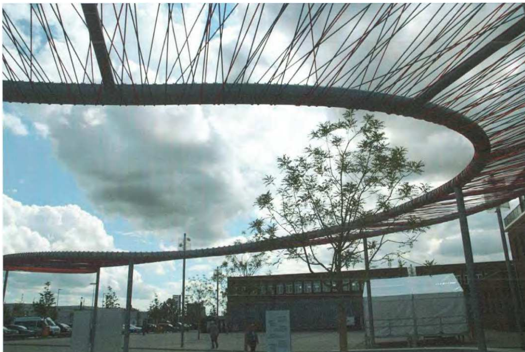
Quartiersplatz auf dem ehemaligen Enka-Gelände mit Pergola. Im Hintergrund das Kantinen- und Werkstattgebäude.
